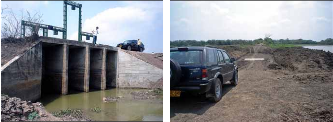
Figura 133: Compuerta y estructura en construcción en la ciénaga El Paraíso. Fuente: CI, 2007
