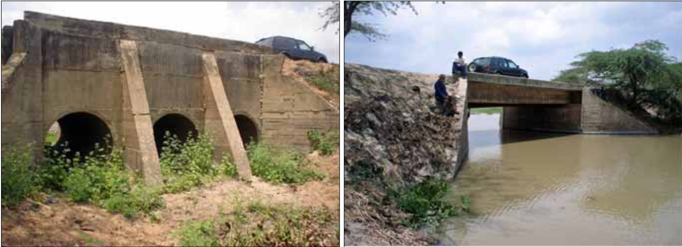
Figura 45: Alcantarilla y puente en el terraplén entre las ciénagas Luisa y Santo Tomas. Fuente: CI, 2007
