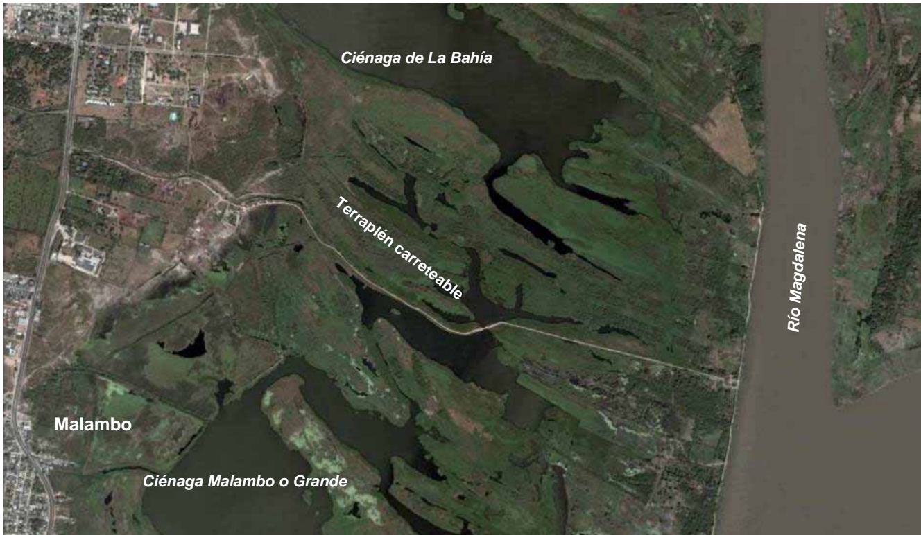
Figura 52: Terraplén carreteable en la ciénaga de La Bahía y obras anexas. Fuente: CI, 2007, sobre imagen de satélite de Google Earth, 2006
