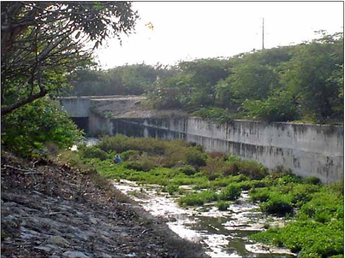
Figura 25: Canalización en concreto del Ay. Caracolí aguas abajo del puente de la Carretera Oriental Fuente: CI, 2007.
