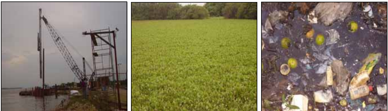
Figura 7: Detalles de la intervención de los cuerpos de agua en la zona de desborde aluvial de los humedales: Infraestructura invasiva, eutrofización por taponamiento de canales naturales, contaminación físico química de arroyos y humedales (municipios de Malambo y Soledad. Fuente: CI, 2007)
