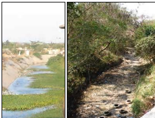
Ilustración 148 Detalle de diferentes lugares del drenaje Pluvial urbano y rural de la Cuenca. Fuente CI, 2005.
