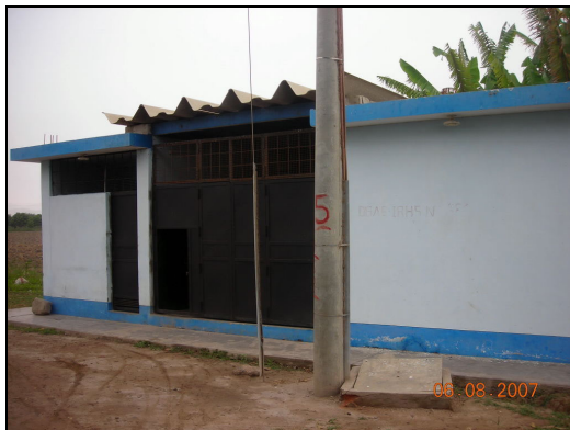
Vista N° 25 Exterior del Pozo N° 5
