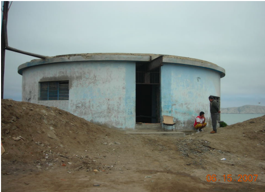
Vista N° 15.- Exterior de la cámara de bombeo Ica
