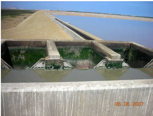
Vista N° 19.- Estructura de distribución de caudales
