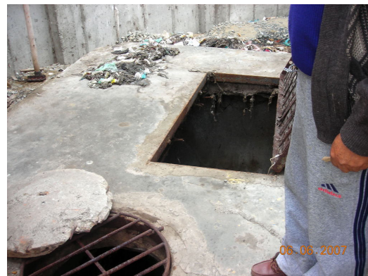
Vista N° 14.- Cámara de rejas EB Palacios
