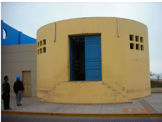
Vista N° 13.- Frontis Cámara de Bombeo Palacios
