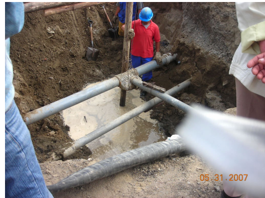
Vista N° 06.- Reparación de líneas de distribución de agua.
