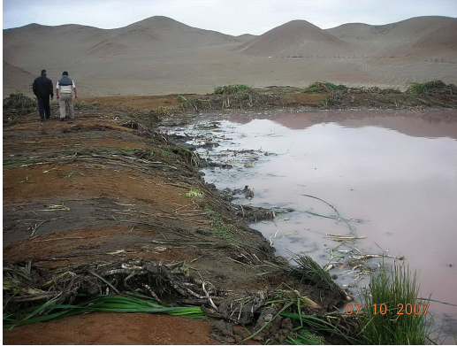
Vista N° 37. Limpieza de taludes de malezas Laguna Primaria Pacaysito
