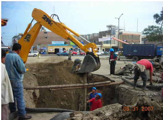
Vista N° 07.- Rehabilitación de colectores de desagüe
