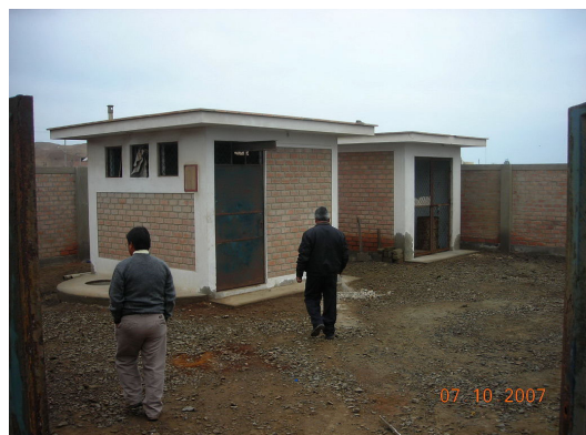
Vista N° 36. Exterior de la Cámara de Bombeo de desagües Puerto Huarmey
