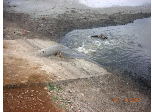
Vista N° 38. Ingreso de desagües laguna primaria Pacaysito
