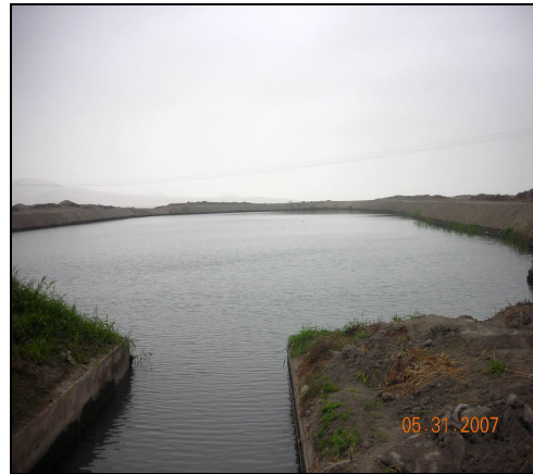
Vista N° 02 Laguna de Presedimentación N° 1.
