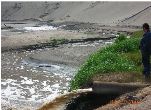
Vista N° 23.- Descarga de desagües Cámara de bombeo Palacios y San Pedro
