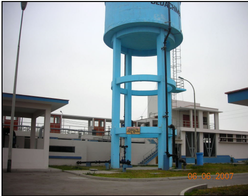
Vista N° 03.- Interior de la Planta de Tratamiento de agua
