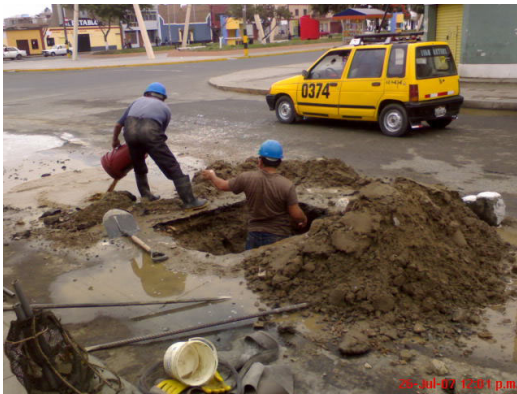
Vista N° 05.- Reparación de rotura tubería de agua.
