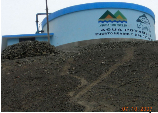
Vista N° 33. Reservorio apoyado 250 m 3 Huarmey
