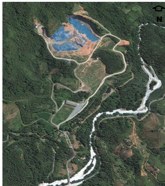
Figura 3.6 Relleno Sanitario La Pradera
